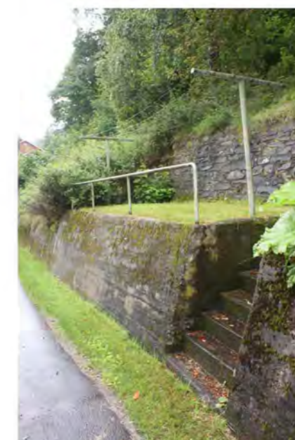
STØTTEMUR NR. 26 og 27
