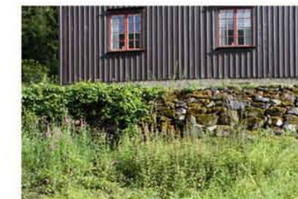
STØTTEMUR NR. 4 OG 5
