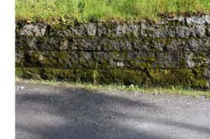
STØTTEMUR NR. 4 OG 5
